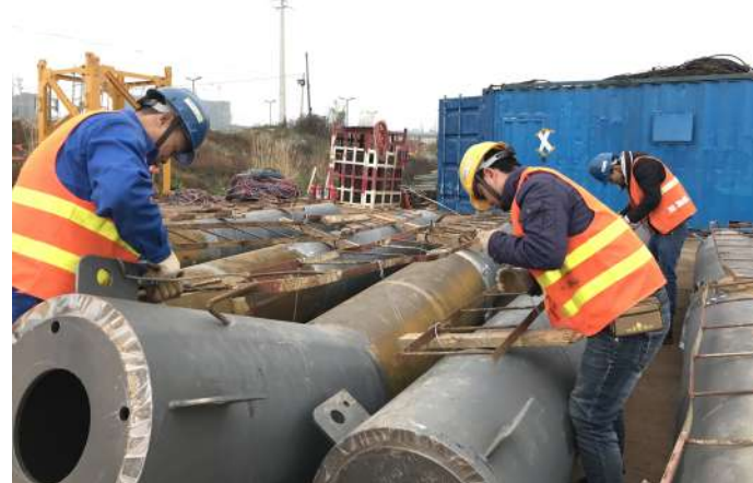
工人在现场紧张施工
