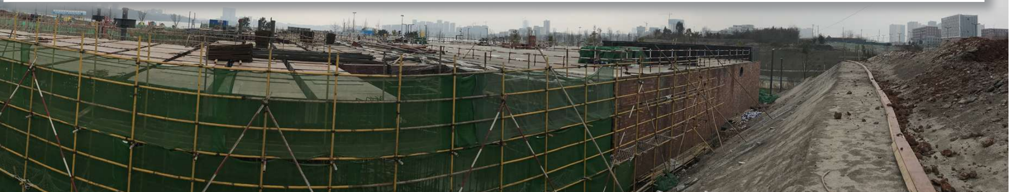
独角兽岛启动区建设现场
